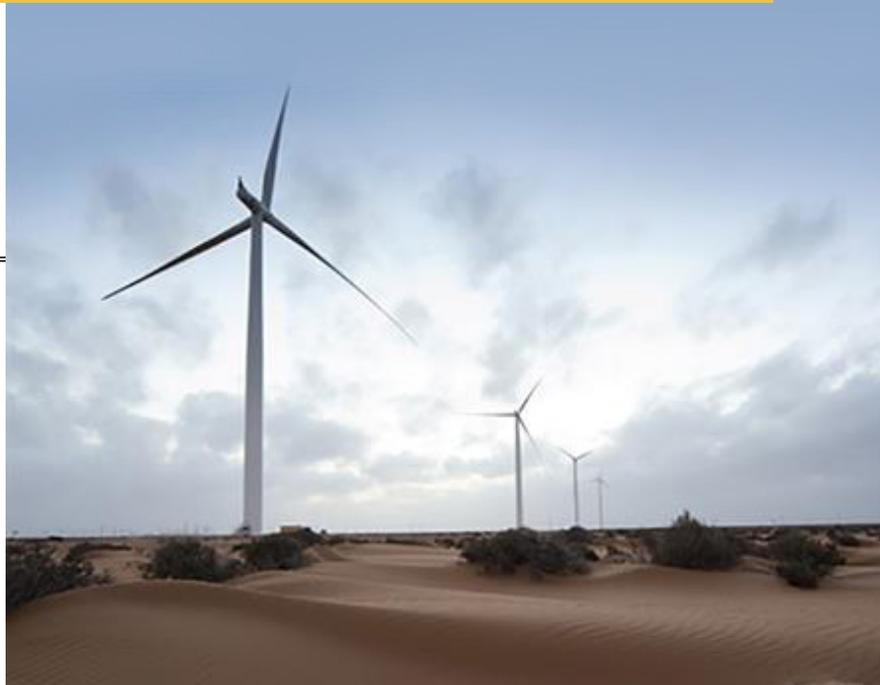
Une partie importante de l'énergie produite par les turbines SWT-DD-130, qui peuvent souffler jusqu'à 4,2 MW de puissance nominale grâce à ses énormes pales de 63 mètres de long, est destinée aux marchés extérieurs, notamment l'Europe, l'Afrique et le Moyen-Orient.
